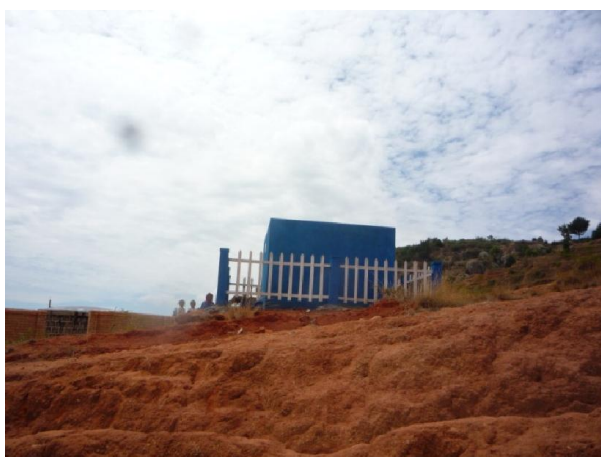
PHOTO N° 3: Réservoir d'eau à Ivatobe
